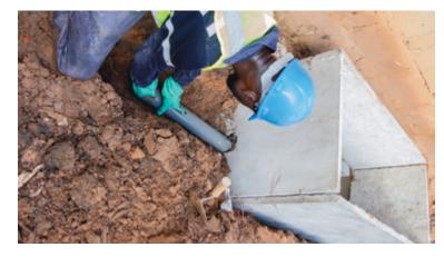
**Plate 30:** Fixing of effluent pipe
