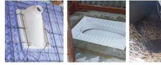
Plate 48: S-trap pour flush into Bio-digest
